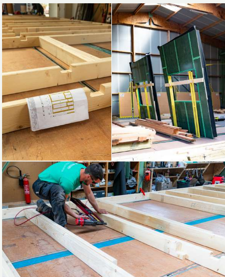
PRÉFABRICATION DES MURS À L'ATELIER
