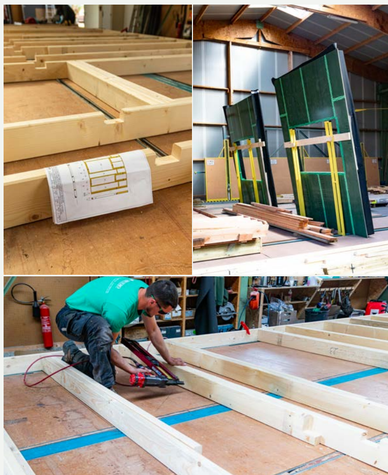
PRÉFABRICATION DES MURS À L'ATELIER
